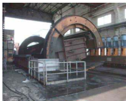
翻卸系统喷雾抑尘治理前
