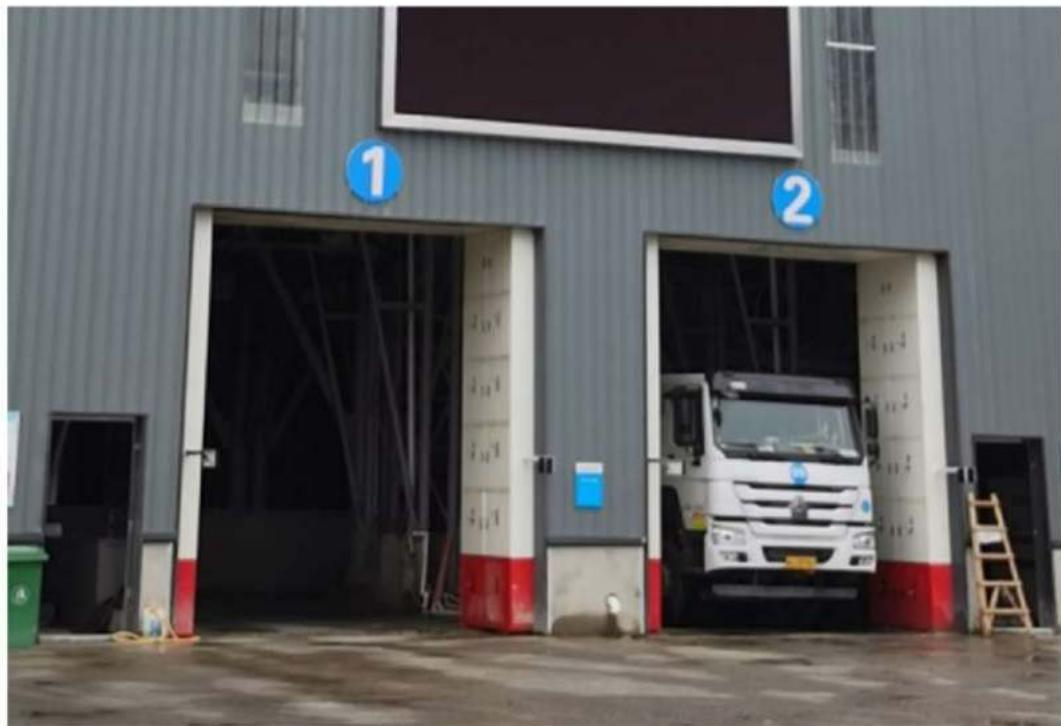
下料口洗车机是长原喷雾针对于某些场地较小的客户专门研制开发的一款新型洗车机。该洗车机采用龙门式结构，安装在下料口门口，不需要占用搅拌站额外场地，该系统侧面采用摇摆式水刀结构，能够进行全车冲洗，顶部设置有顶喷，地面设置有底盘冲洗。对于搅拌车的料斗设置有下料斗冲洗。整个系统采用全自动控制，操作简单方便，功能强大。
